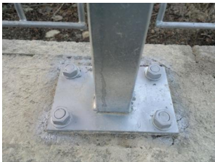
KOTVENÍ SLOUPKU DO ZÁKLADOVÉ PATKY
